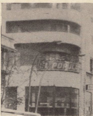
Fachada del edificio del diario EL POPULAR
