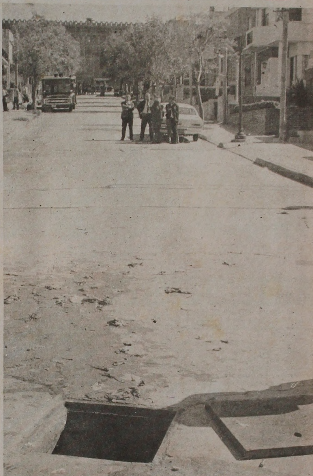
UNA TAPA LEVANTADA Y POR LA CUAL ACCEDIERON LOS BOMBEROS A LA CLOACA DE LA CALLE PORTO ALEGRE EN BUSCA DE LOS EVADIDOS QUE YA ESTABAN MUY LEJOS.
