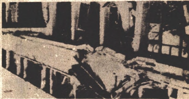
HANOI. - LA TERMINAL AEREA DESTROZADA
