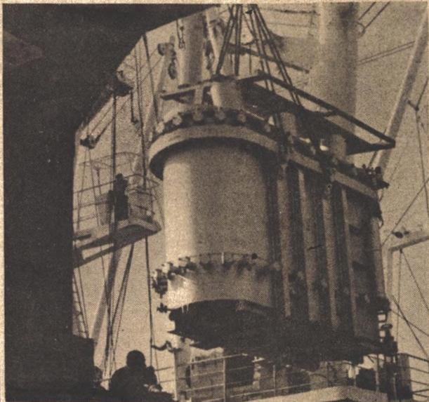
En la tarde del viernes con dos días de atraso respecto a la fecha prevista para su arribo al puerto de Montevideo, se ha procedido a la descarga del transformador principal de 15.000 KVA que servirá para la próxima interconexión de Salto al sistema hidroeléctrico nacional.
