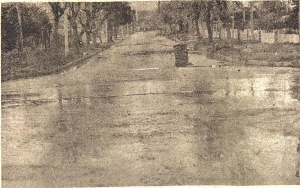
El pavimento de la calle Minuanes era bueno. Poco a poco -aguas servidas mediante- se fue deteriorando. Ya se han producido varios accidentes por dicho motivo
