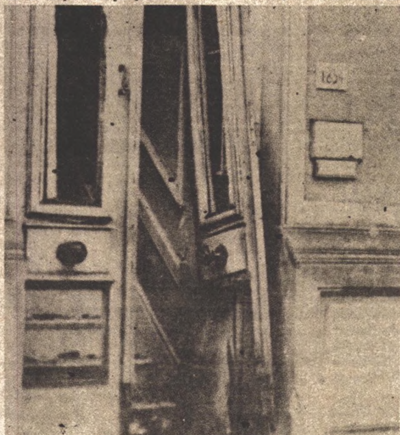
EL ESTADO EN QUE QUEDO LA PUERTA DE UNA DE LAS FINCAS DONDE COLOCARON ARTEFACTOS EXPLOSIVOS.
