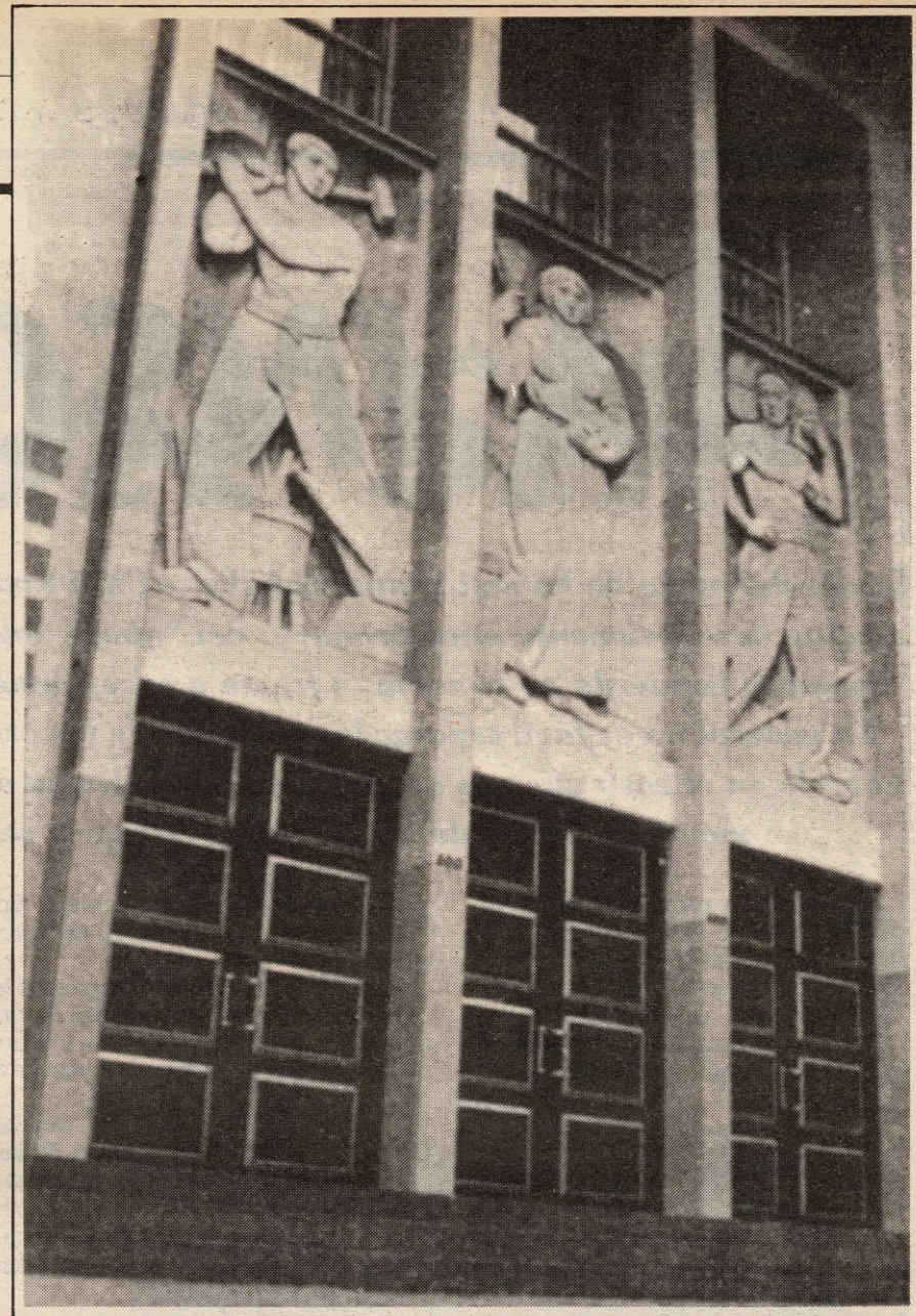
Banco la Caja Obrera: en la mira de la privatización.
