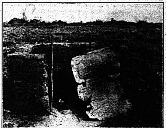
No existen ni las más mínimas condiciones higiénicas y sanitarias
